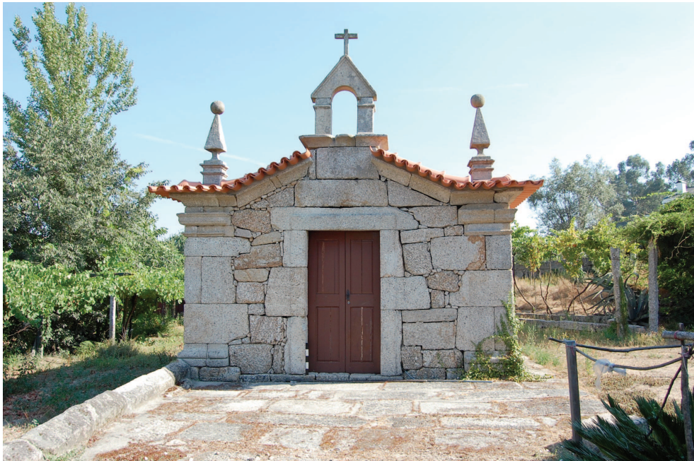
Fig. 15 – Fachada da capela de Santo António
