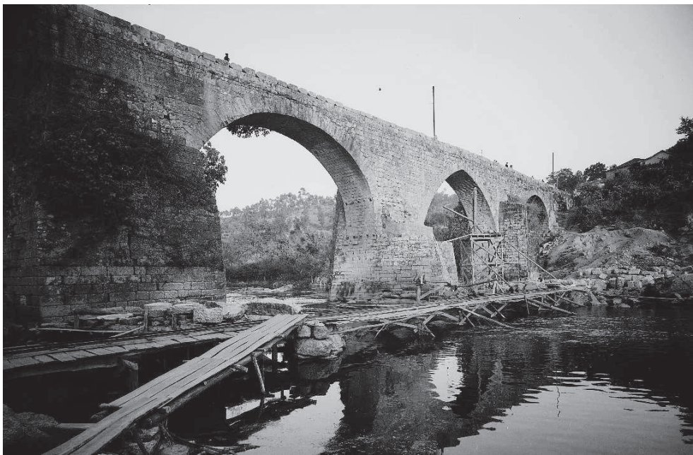
Fig. 2 – Antiga ponte de Canaveses, presentemente demolida. Fotografia obtida em SIPA
