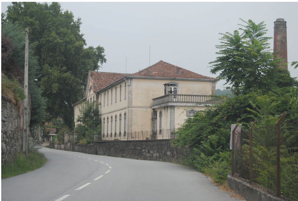
Fig. 1 - Vista geral sobre o edifício das Caldas de Canaveses
