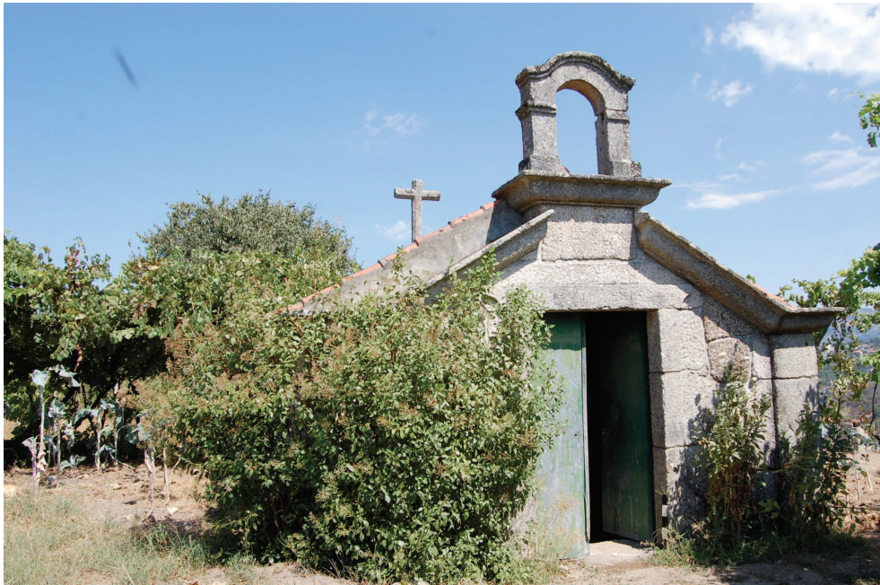
Fig. 17 – Fachada da capela de São Pedro, voltada a Oeste
