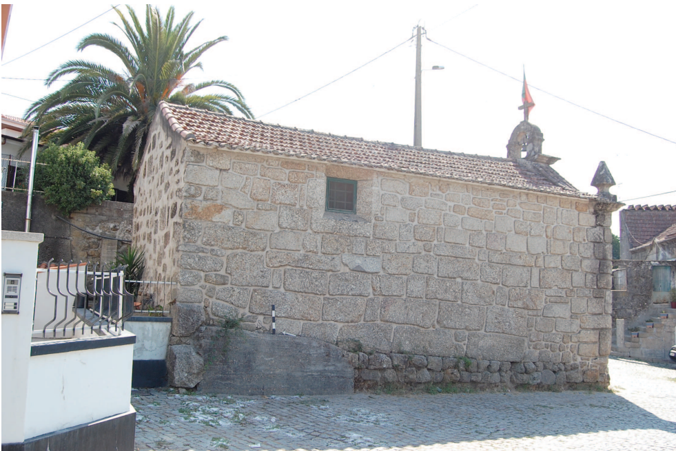
Fig. 24 – Alçado lateral sudoeste da capela de São Sebastião
