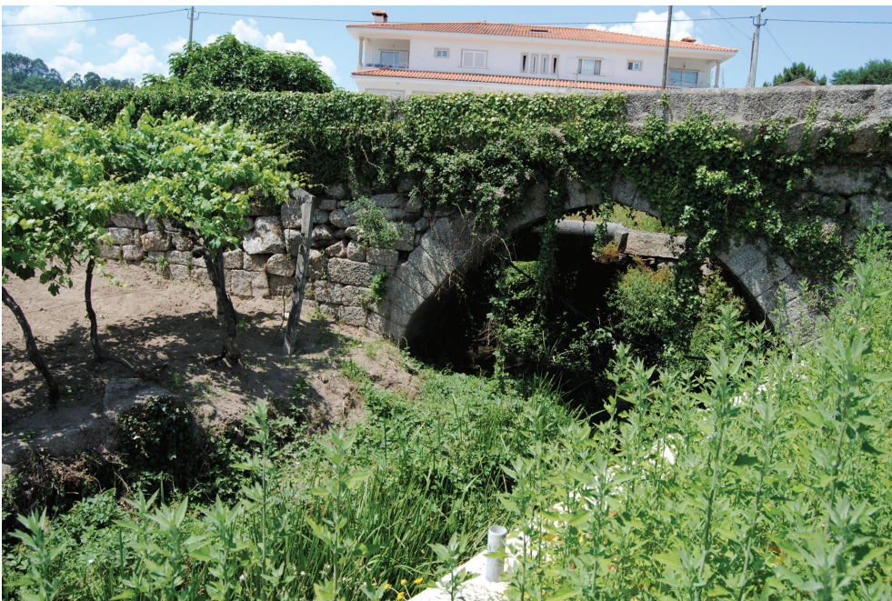
Fig. 9 – Enquadramento da ponte dos Asnos obtido de jusante
