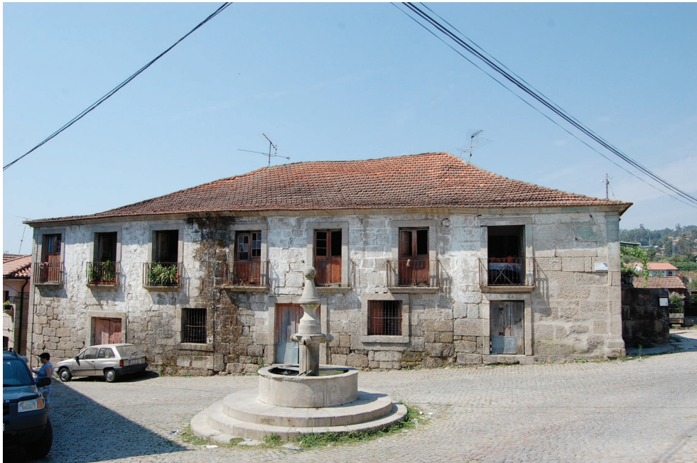
Fig. 12 – Fachada da Casa do Terreiro do Santo ou Casa Grande de Sobretâmega
