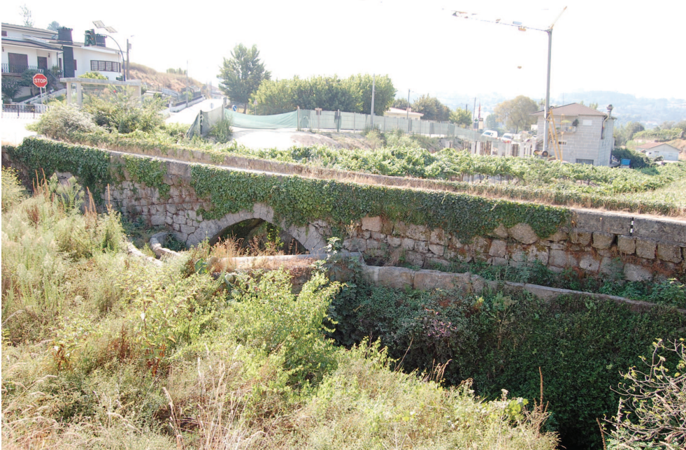
Fig. 8 – Vista de Norte sobre a ponte dos Asnos
