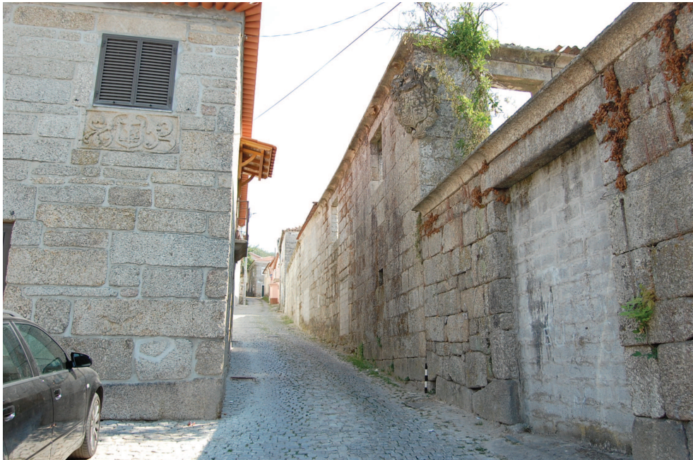
Fig. 21 – Alçado noroeste da casa de Fontáido, em ruína
