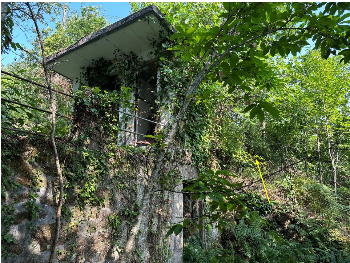
Casa de banho exterior
