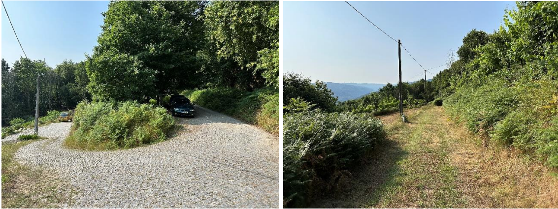
Vista de infraestruturas presentes nos arruamentos que servem o prédio
