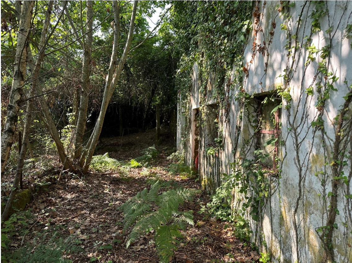
Alçado Principal e logradouro (vedado com rede)
